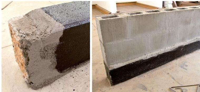
As superfícies de concreto, alvenaria ou revestimento em contato direto com a terra deverá estar limpas, secas, isentas de óleos, graxas e partículas soltas de qualquer natureza.
