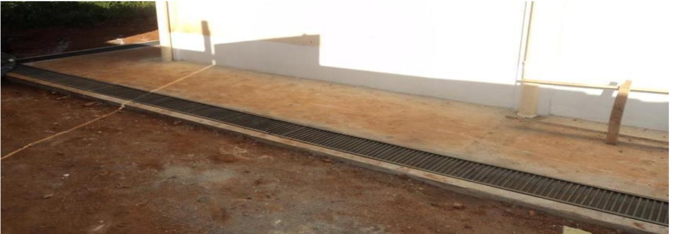
**90200. CANALETA EM TUBO DE CONCRETO MEIA CANA PARA ÁGUAS PLUVIAIS.**
