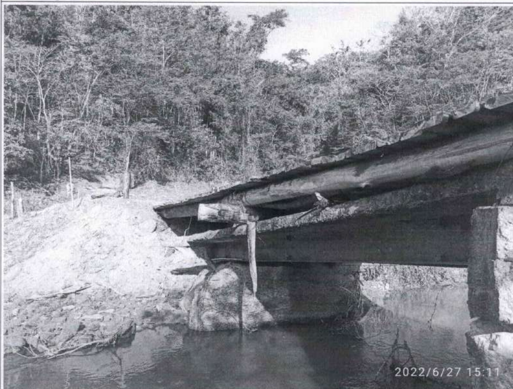
Figura 02) Apoio da ponte danificada utilizada para apoio em madeira. Datado de 27/06/2022 (apresentado no canto inferior direito).
