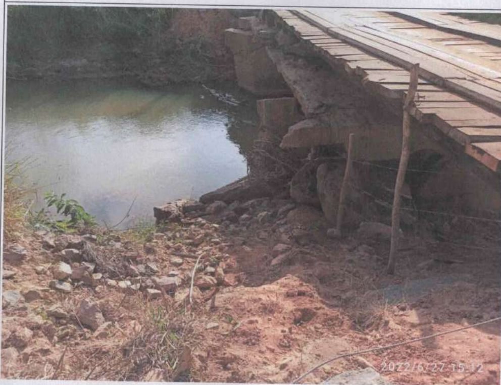
Figura 03) Apoio da ponte danificada utilizada para apoio em madeira. Datado de 27/06/2022 (apresentado no canto inferior direito).
