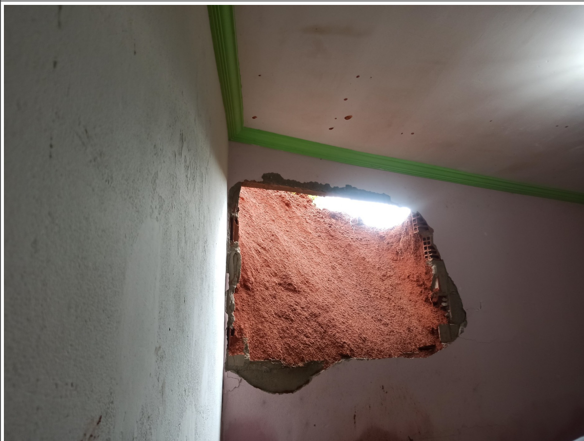
Figura 03) Deslizamento de terra e desabamento de parede em imóvel.
