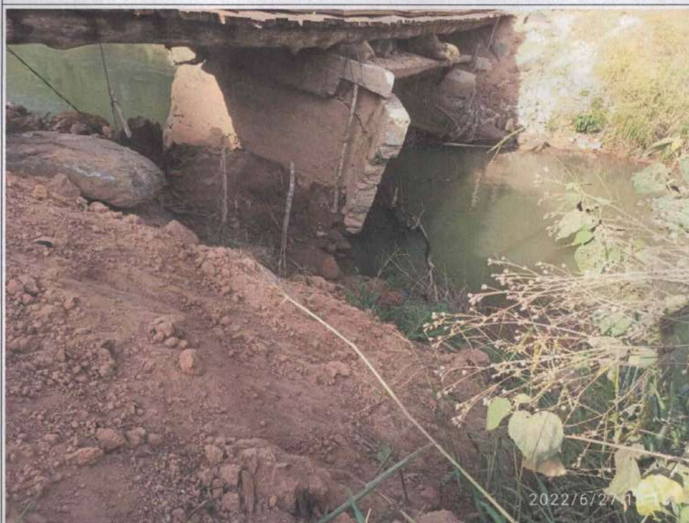
Figura 01) Estrutura da ponte danificada utilizada como apoio para a colocação de tabuleiro em madeira. Datado de 27/06/2022 (apresentado no canto inferior direito).
