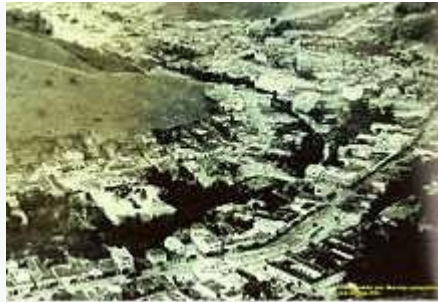
Vista parcial de Caratinga por volta de 1940
